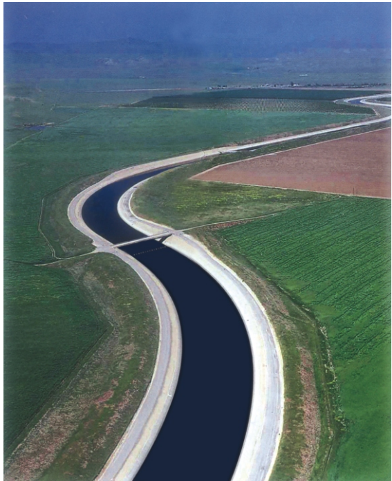
Cống dẫn nước California là một phần quan trọng của cơ sở hạ tầng tại tiểu bang này.
